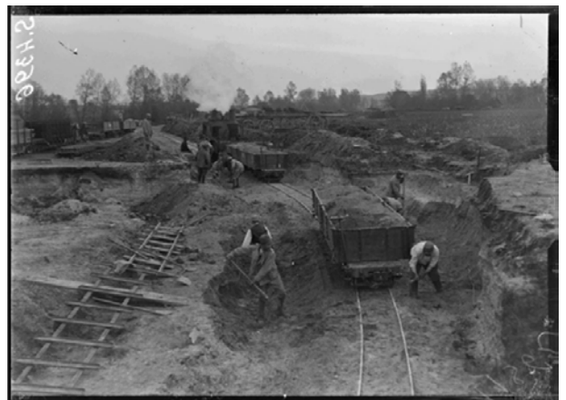
Réf. SPA 120 S 3496 - Pernant (Aisne). Soldats italiens installant une voie de 0,60. A gauche, deux travées de 5 m, dont l'une est à l'envers, montrant le profil en creux des traverses. 14 mai 1918, Emmanuel Mas
