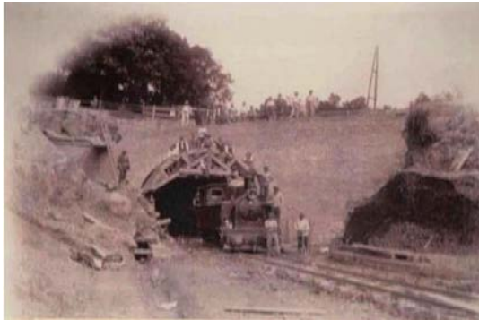
Photo prise lors de la construction du tunnel de Burziheid entre 1909 et 1911
