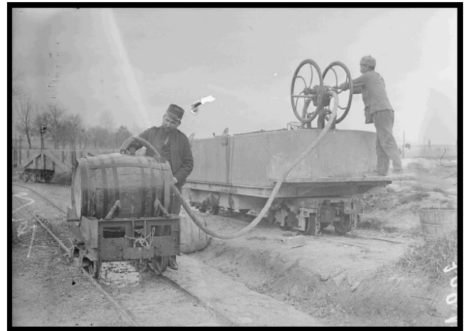
Réf. SPA 18 N 607 – Région de Suippes (Marne). Wagon citerne « station des abeilles ». Il s'agit d'une citerne prismatique Modèle 1888 (7 m 3 ). 23 novembre 1916, Pierre Pansier
