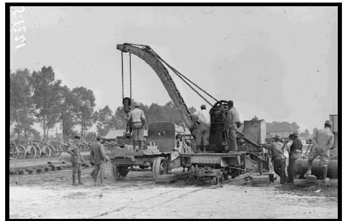
Réf. SPA 33 S 1721 – La Neuville-Sire-Bernard (Somme). Manœuvre d'une grue Péchot-Magnard et déchargement d'un canon de 120 mm long éclaté. Juillet 1916, Emmanuel Mas
