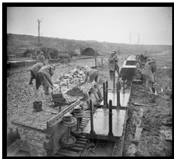
Réf. SPA 54 L 2565D – Fort de Douaumont (Meuse), wagonnets Decauville pour les travaux de réfection des abords du fort. 19 avril 1917, Albert Samama-Chikli
