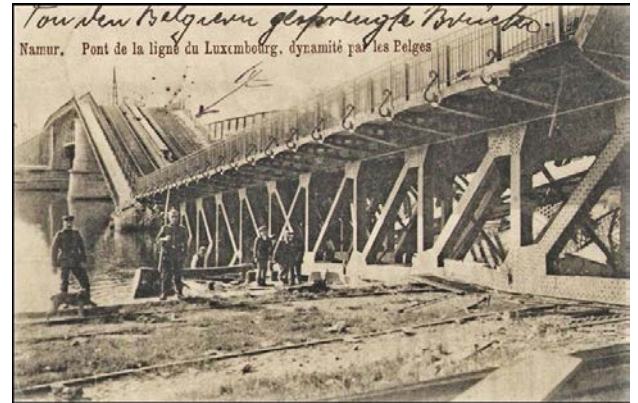
Viaduc de Namur dynamité par les Belges en 1914
