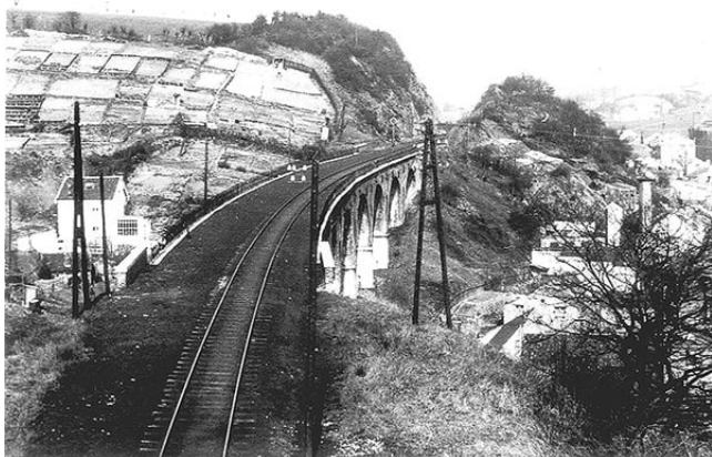
Vue plongeante du grand viaduc, depuis le haut du portail nord du Tunnel de la Pisseroule (photo Entre-Voies ???)
