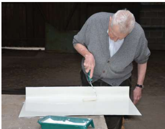
Application d'une peinture anti rouille sur les nouvelles tôles de la « 82 »
