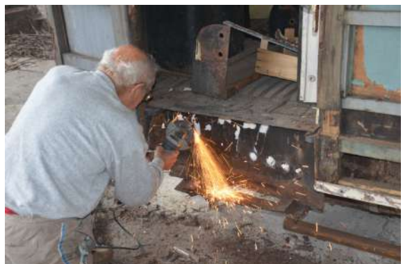
Démontage des marches-pieds de l'Enghien Saint-Eloi 82
