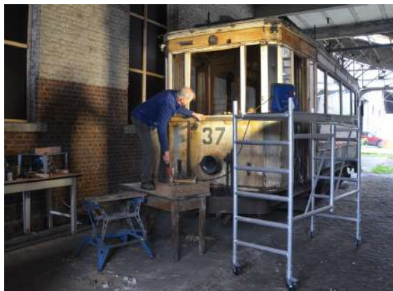
Réparation du châssis vitré de l'arrière de la Germain 37.
