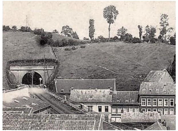
Le Tunnel de Dison sous la colline du Sacré-Coeur
