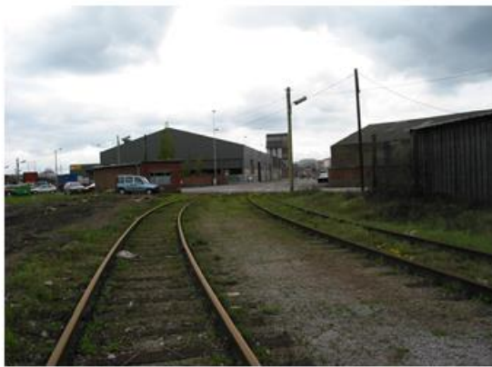
PHOTO 4 : Port de Monsin – ligne industrielle 214 raccordement de la voie 42 (darse sud). Rayon de courbure de 89 m. Correspondance en N 556 mm / en HO 1,23 m. Vitesse autorisée à 5 km/h. Pour un rayon de courbure inférieur à 150 m. de rayon le desserrage des tendeurs est obligatoire.
