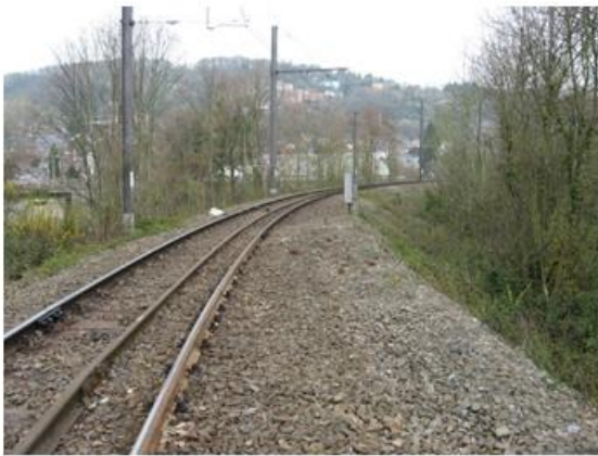
PHOTO 4 : Port de Monsin – ligne industrielle 214 raccordement de la voie 42 (darse sud). Rayon de courbure de 89 m. Correspondance en N 556 mm / en HO 1,23 m. Vitesse autorisée à 5 km/h. Pour un rayon de courbure inférieur à 150 m. de rayon le desserrage des tendeurs est obligatoire.
