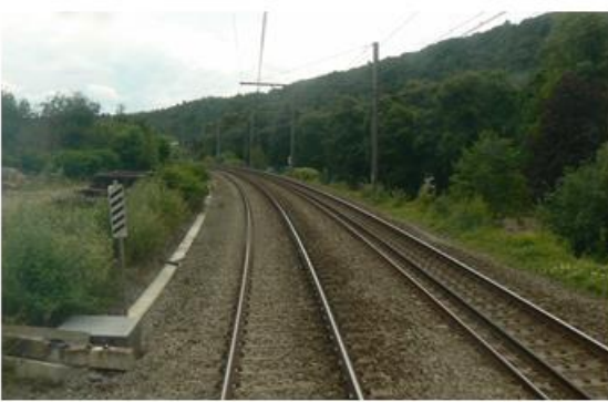
PHOTO 5 : ligne 37 sortie du tunnel de Hauster (à comparer avec la photo 2 – 38 ans d'intervalle entre les deux photos). Vue vers l'arrêt de Chaudfontaine. Pour rappel, courbe de 494 m de rayon. Le dévers est ici de 90 à 120 mm selon l'endroit de la courbe. A noter en entrée de courbe l' arc de transition (raccordement parabolique).
