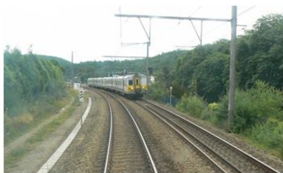
PHOTO 12 : ligne 37 – dans le fond le point d'arrêt de Chaudfontaine. A l'endroit de la prise de vue, le rayon de courbure est de 507 mètres. Entraxe évalué à 3,635 m. (N : 22,7 mm / HO : 42,8 mm).
