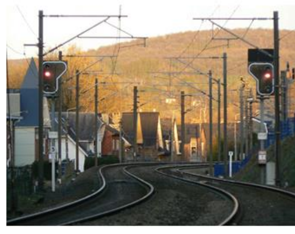
PHOTO 9 : ligne 42 – courbe et contre-courbe en sortie de la gare d'Aywaille vers Trois-Ponts. Le segment en alignement est de 75 m. (soit 470 mm en N et 860 mm en HO).
